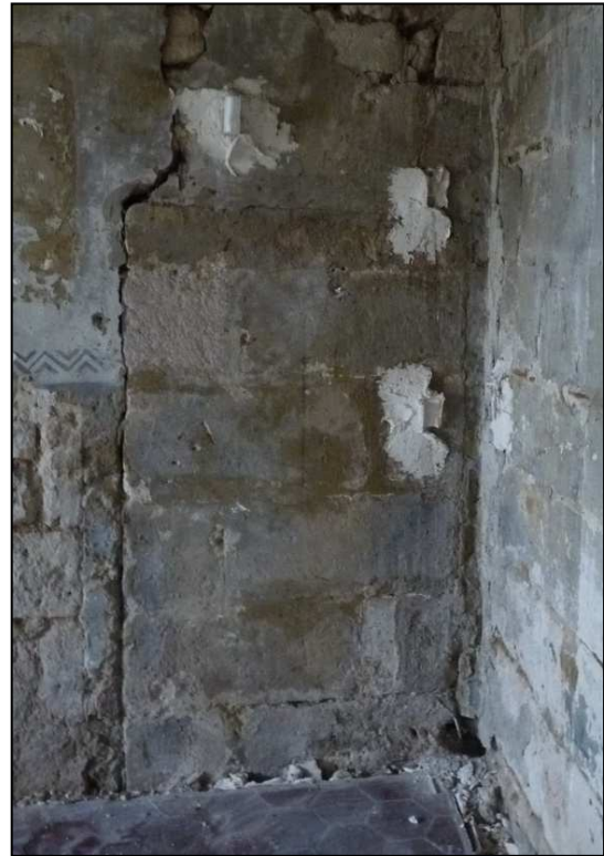
Traces d'une autre porte (seconde pièce à gauche de l'escalier central)
