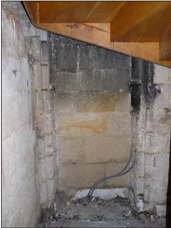
Traces de l'ancienne porte sous l'escalier central
