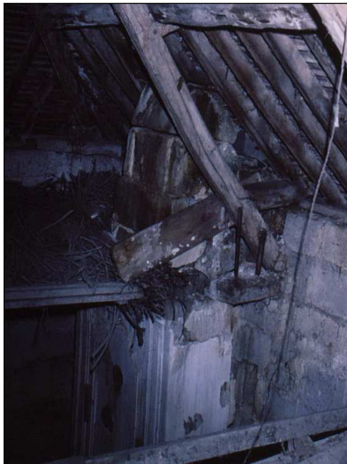
La cheminée disparue avec son conduit, vue de l'étage (1989)
